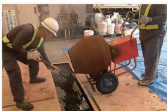
⑪ 特殊合材敷均し
