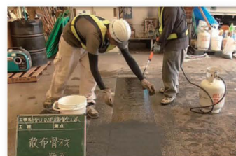
⑯ 仕上工 バインダー塗布・骨材散布
