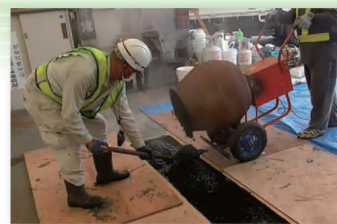
⑬ 表層合材敷均し
