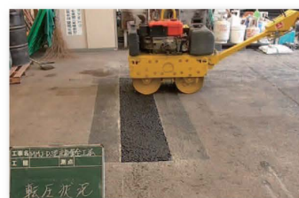
⑮ 表層合材機械転圧
