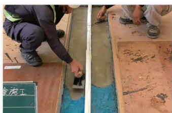
④ 打継用超速硬モルタル打設
