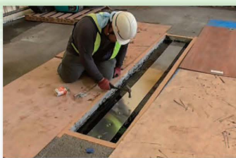
⑦ ギャッププレート設置
