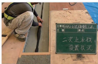
⑤ 二次止水構造 特殊発泡材設置
