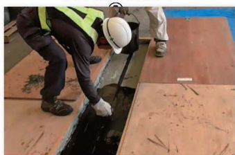
⑥ 施工基面バインダー塗布
